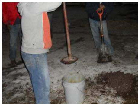
Figura 15. Compactación de la mezcla para formar el bloque.
