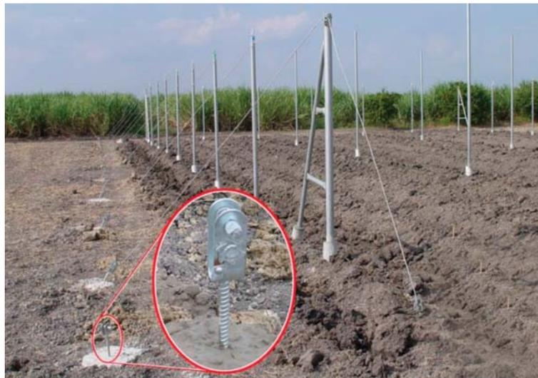
**Figura 3. Ejemplo de utilización de las carracas.**
