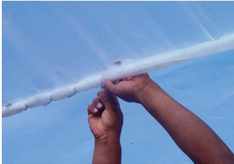
**Figura 10. Unión de la malla a las trenzas y cordones.**
